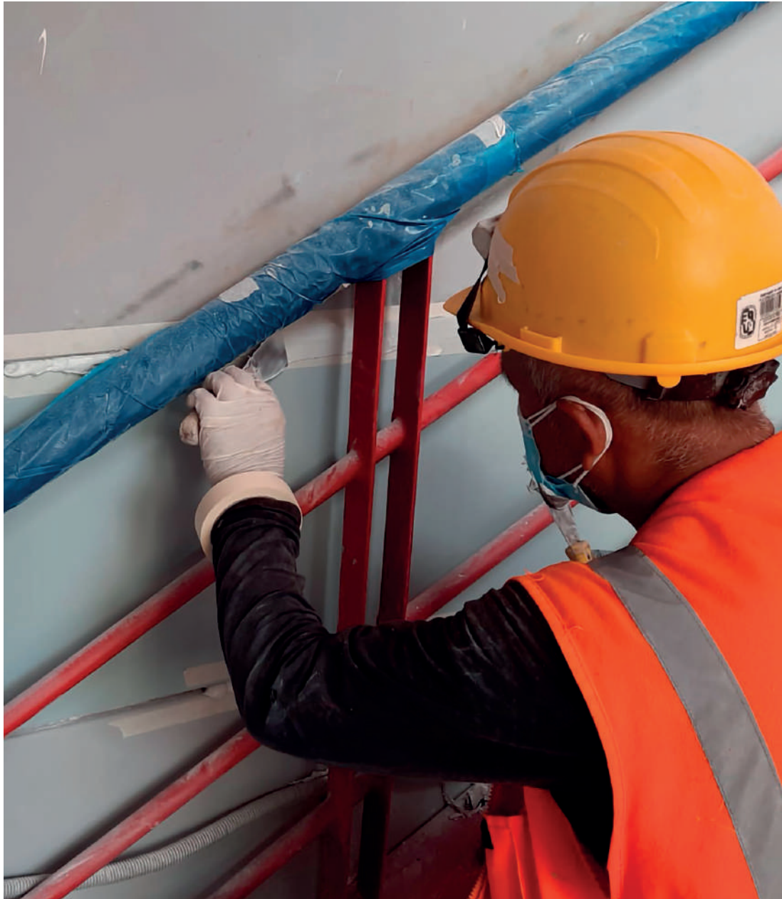
Compartimentación y sistemas cortafuego en escaleras de emergencia - Instituto SISE Santa Beatriz
